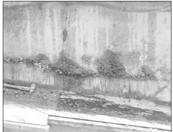
(d) Offsets in Concrete Joint
